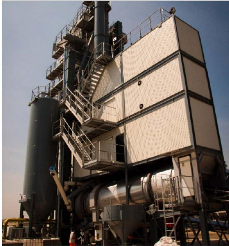
Per evitare le possibili corrosioni dovute alle condense acide all'interno del filtro (il vapore aspirato dal filtro, se scende sotto ai 100 °C, potrebbe creare degli acidi dovuti alla presenza di tracce di zolfo all'interno dei gas), la parte superiore dello stesso, viene costruita in Corten.
